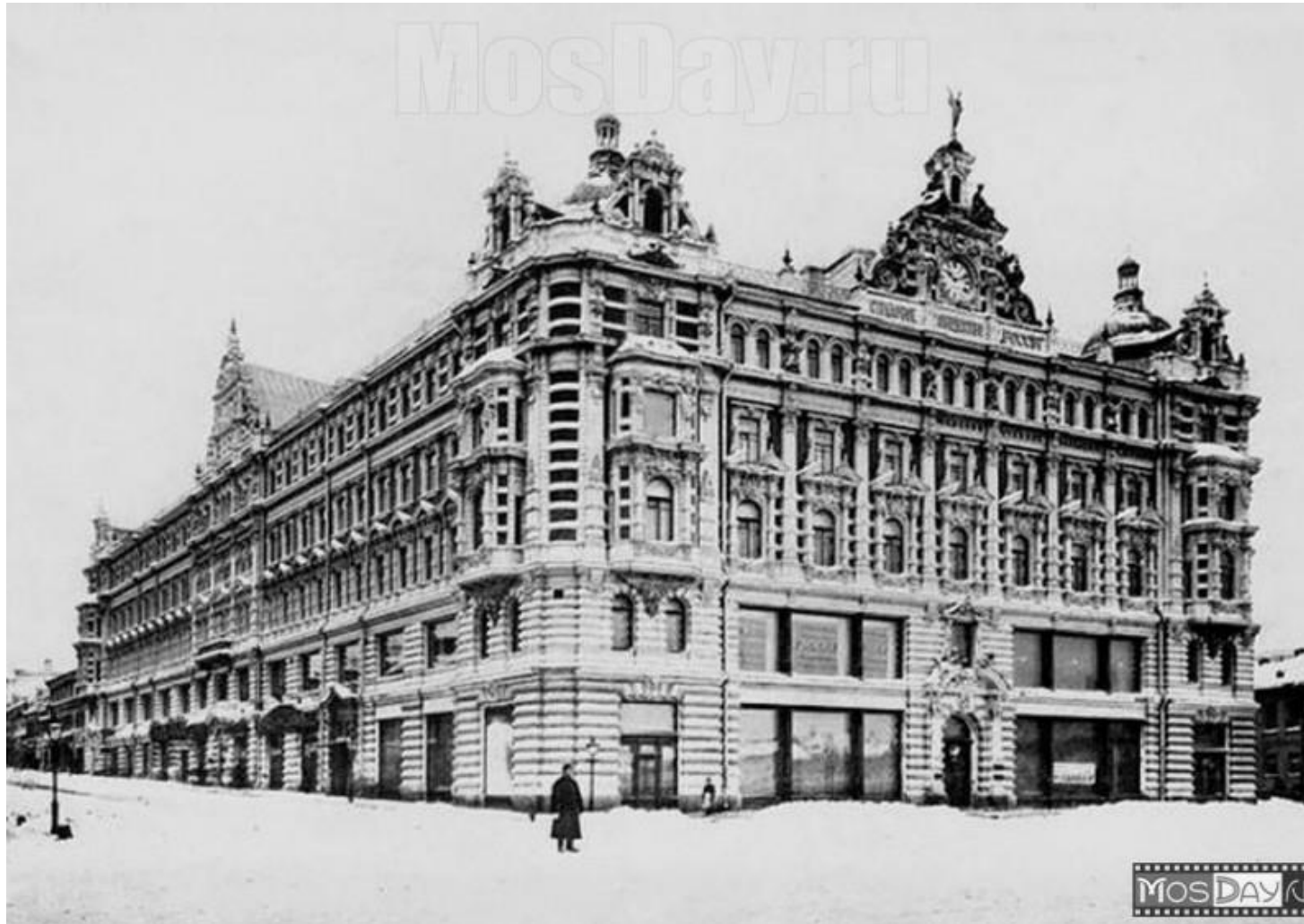
Фото здания в 1894 году.
