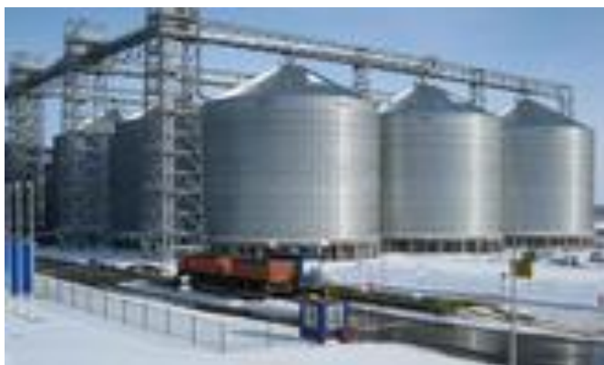
Рисунок 3 - Вентилируемый плоскостонный силос Вгоск;
