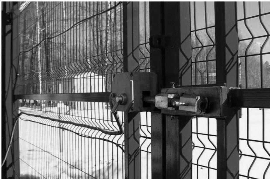
Рисунок 4 – Пример установки замкового устройства на воротах
