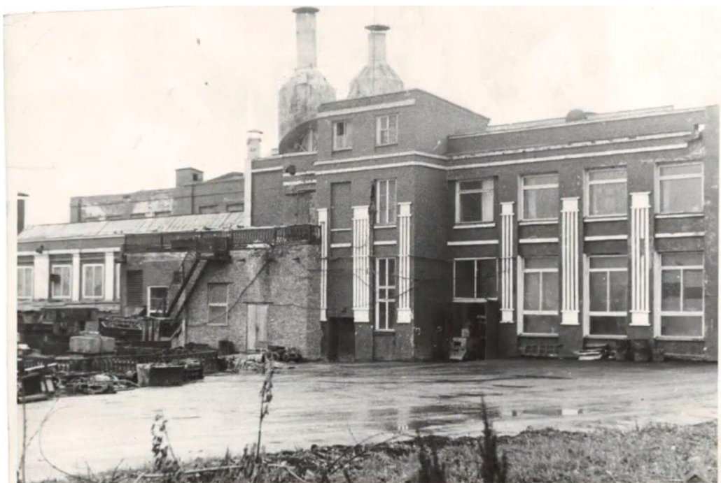
Рисунок 32 – Здание литейного цеха
