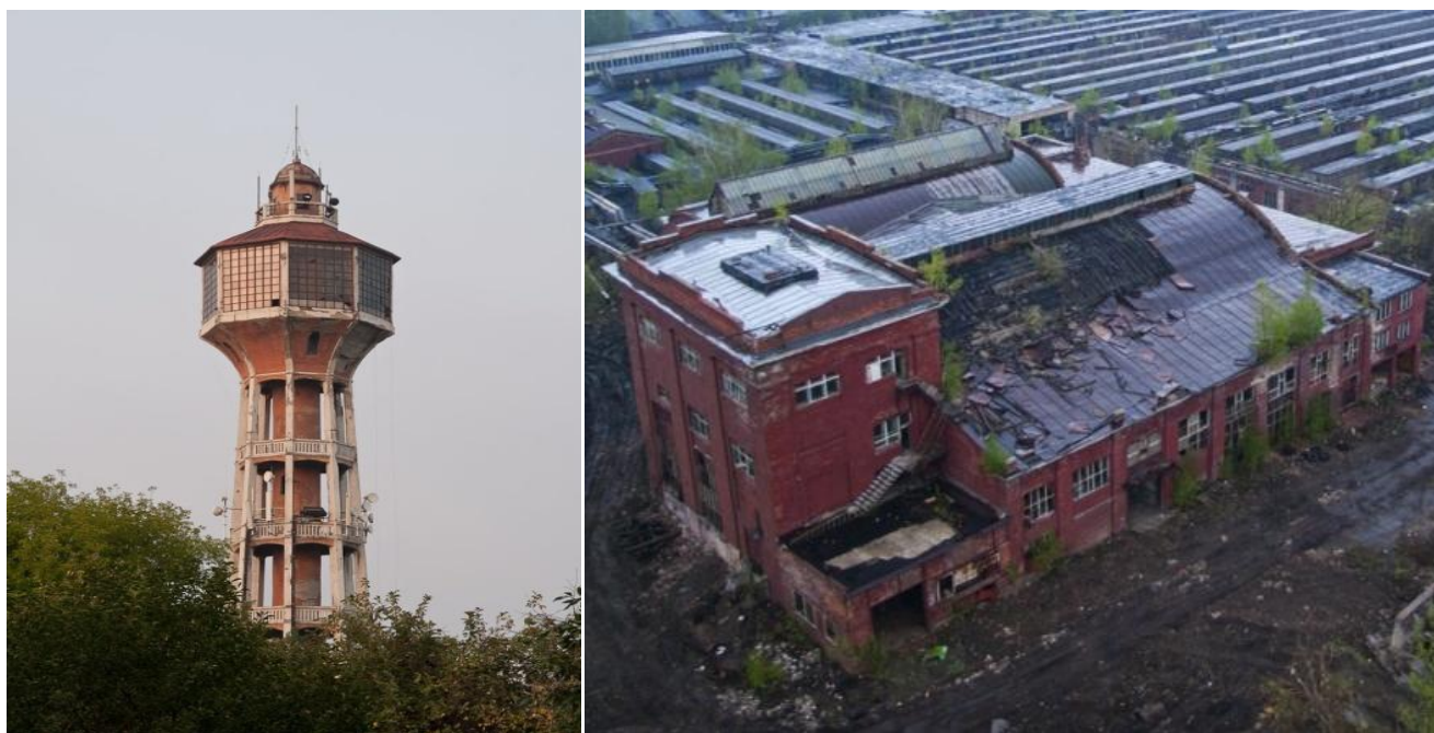
Рисунок 31 – Водонапорная башня и вид с нее на здание электростанции
