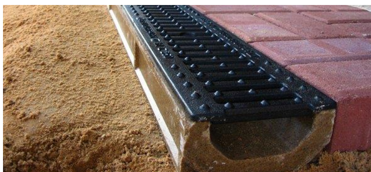
Рисунок 2.2 – Пример укладки водоотвода с решеткой
