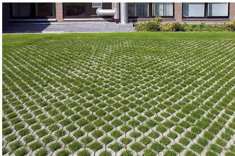
Рисунок 2.10 – Пример укладки газонной решетки
