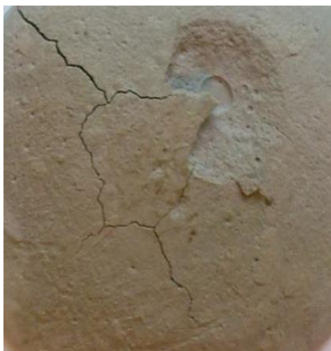
Рисунок 19 – Трещины на образце, полученные при температуре 800 °С
