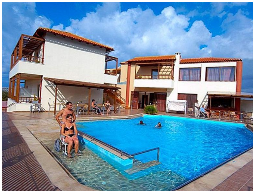
Рисунок 12 – Оборудование бассейна для человека на инвалидной коляске
