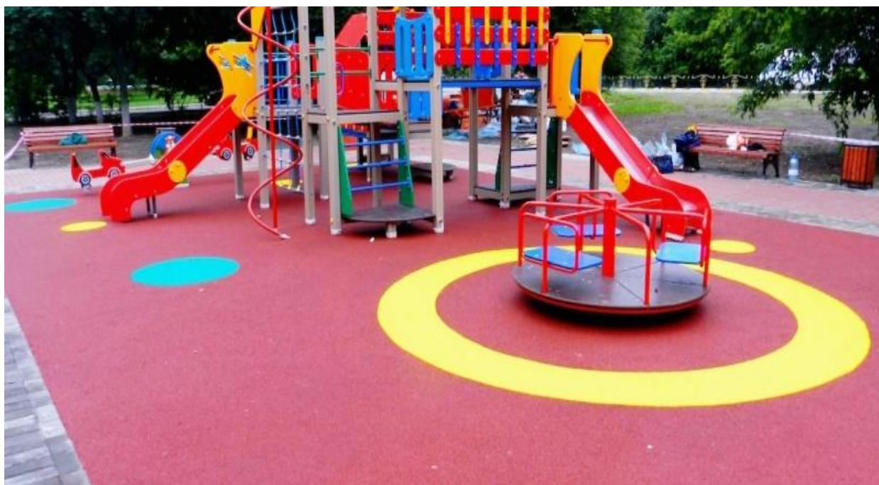
Рисунок 2.1 - Детская площадка с покрытием из резиновой крошки
