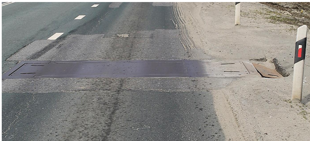
Рисунок 1.15 – Весы нажимного типа, встроенные в дорожное полотно
