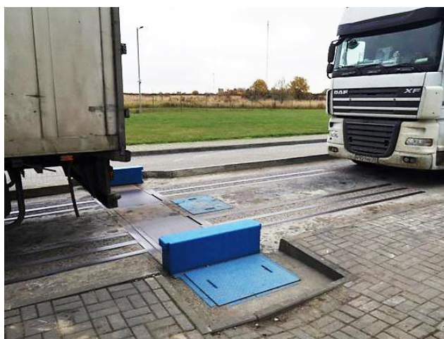
Рисунок 2.4 – Усиление подъездных путей металлическими лонжеронами
