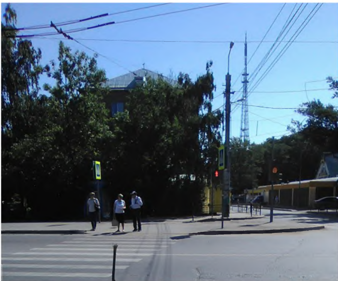
Рисунок 1.3 – Внешний вид перекрестка после завершения реконструкции в октябре 2018 года
