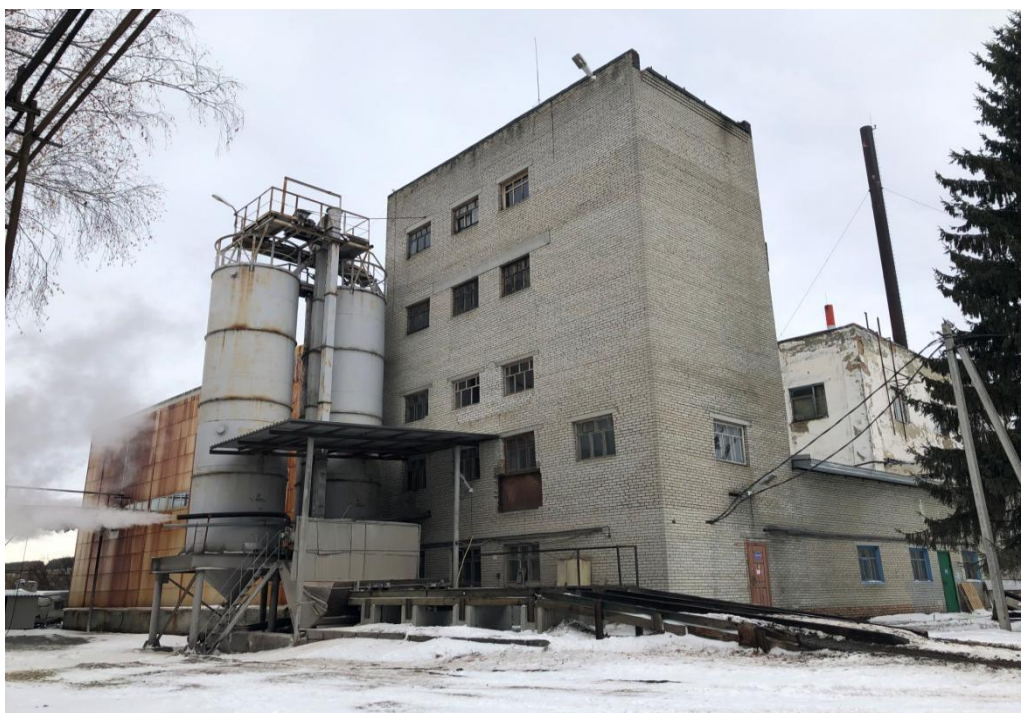
Рисунок 2.2 — Производственный корпус ООО «Ардымспирт»
