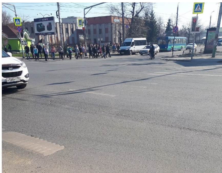
Рисунок 1.25– Износ разметки «Зебра» на пешеходном переходе
