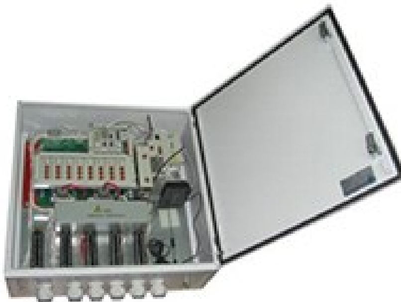
Рисунок 1.18 - Дорожный контроллер «Каскад»
