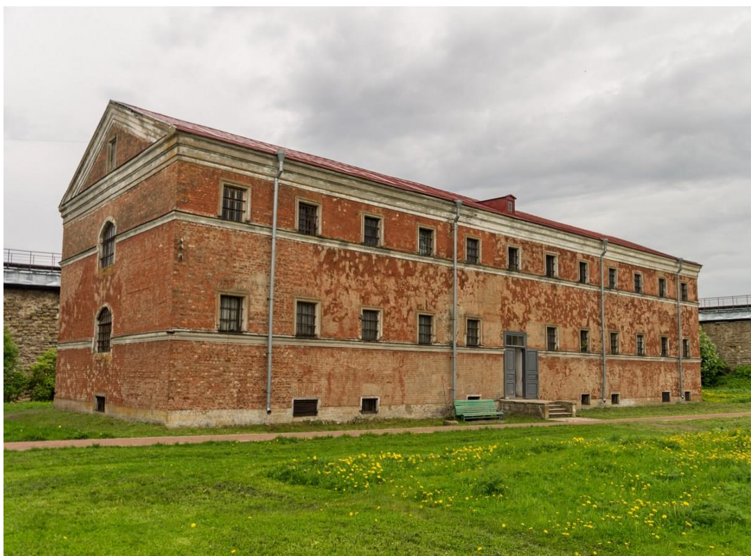
Здание Новой тюрьмы.
