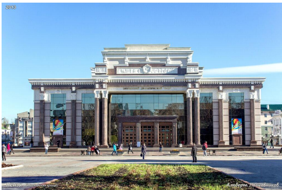
Рисунок 12 – Здание Драматического театра г. Пенза
