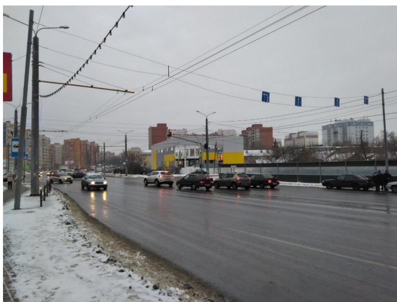
Рисунок 1.7 – Качество дорожного полотна
