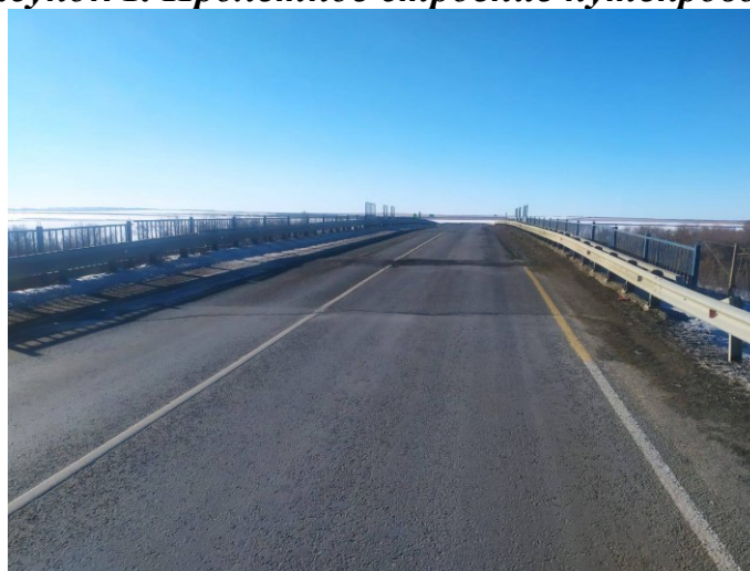
Рисунок 2. Подходы к мостовому полотну путепровода и зона сопряжения
