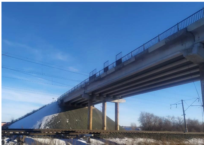
Рисунок 1. Пролетное строение путепровода
