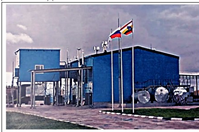
Рис. 1 Комплекс производства гранэмита на Михайловском ГОКе
