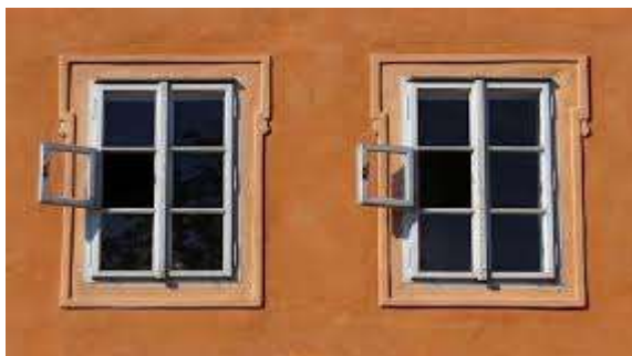
Рис. 1. Окно: форточка – форточка, обвязка – боостворка – белме
