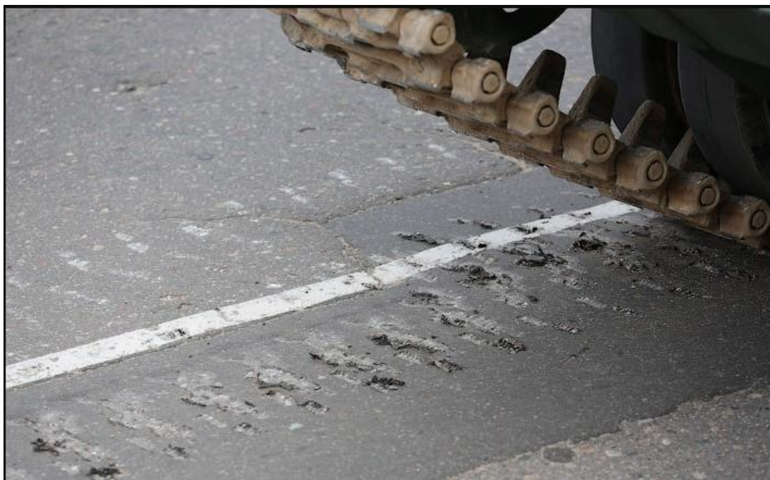
Рисунок 1 – Разрушение АБП
