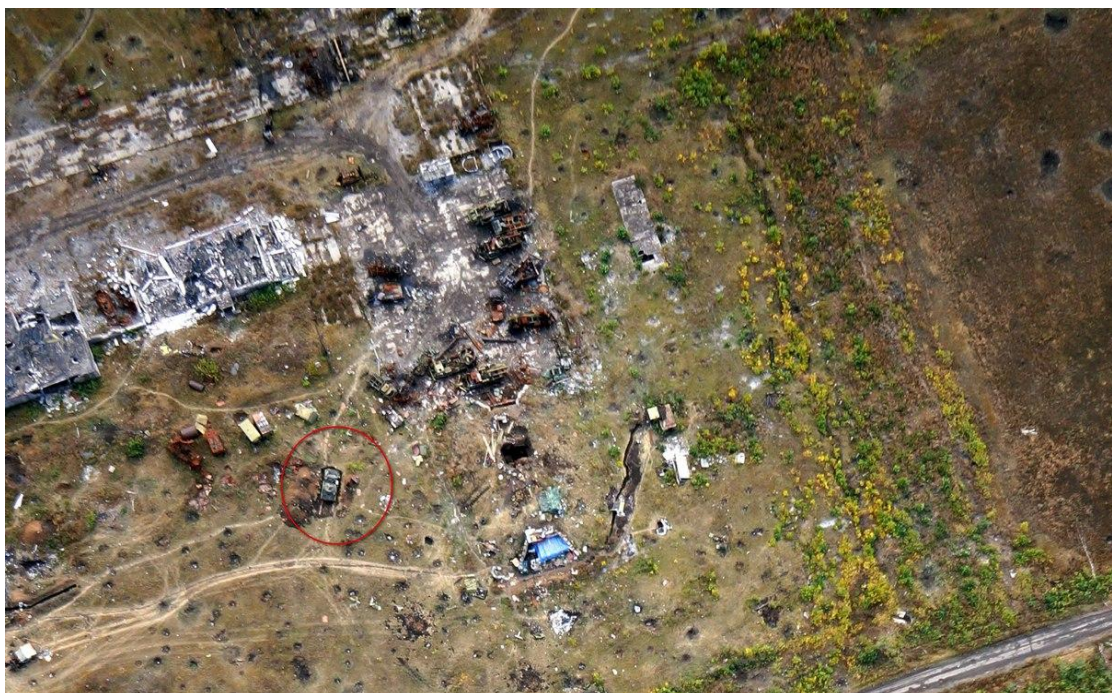
Рисунок 2 – Съемка с БПЛА поврежденной техники на территории ДНР 2015 год
