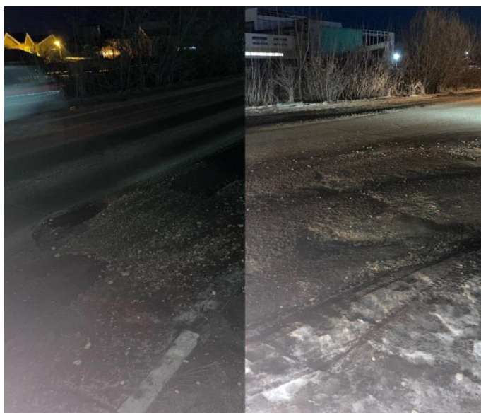
Рисунок 1 – Дорожное покрытие села Засечное
