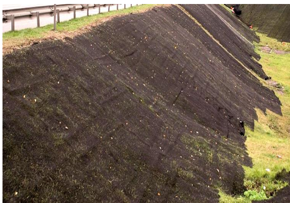
Рисунок 1 – Применение противоэрозионного материала геомата марки Энкамат 7225
