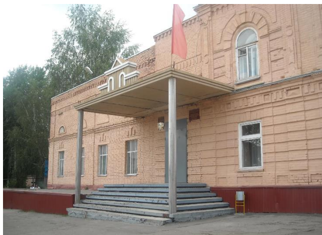
Фото 2. Здание районного Дома культуры
