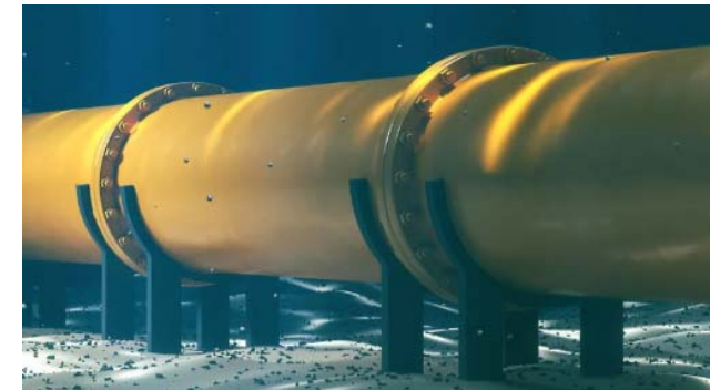
Рис. 1 Опора для подводного трубопровода
